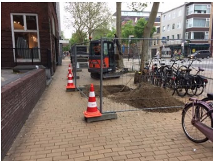
Waterbedrijf Groningen installeerde sensoren op zeven locaties in het drinkwaterdistributienet van de stad Groningen om continu het elektrisch geleidend vermogen te meten
