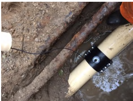
Figuur 6. Installatie door Waterbedrijf Groningen van conductiviteitssensoren in distributieleidingen van het casestudiegebied.
