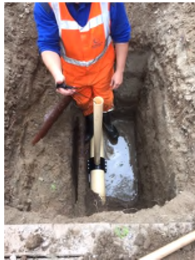
Figuur 6. Installatie door Waterbedrijf Groningen van conductiviteitssensoren in distributieleidingen van het casestudiegebied.
