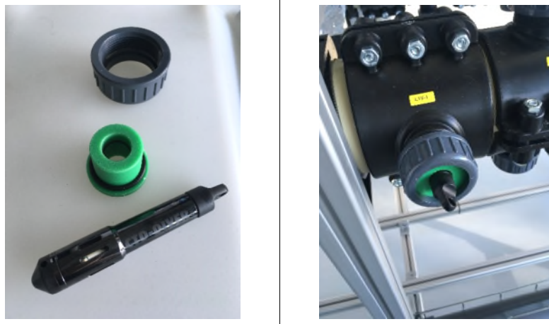
Figuur 2. Voorbereiding van sensoren voor installatie op drinkwaterleidingen. (Links) CT-DIVER sensor, kraagbus, O-ring en wartel, (rechts) montage van de sensor met een aanboorzadel op een PVC Ø110 mm leiding.
