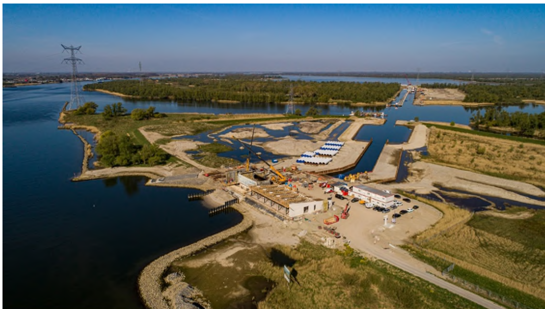
Figuur 8 Werkzaamheden aan het nieuwe innamepompstation aan de Bergse Maas. Het innamepompstation is gelegen in de Fortunapolder, hierachter is het vaarwater van de Spijkerboor zichtbaar met daarachter de graafwerkzaamheden voor de nieuwe transportleiding op de Sint Jansplaat.
