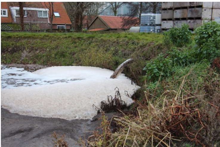
Figuur 3-8: Spoelbasin van bedrijf 2. Het schuim wordt veroorzaakt door suikers in de bollen. Met close-up van watermonster.
