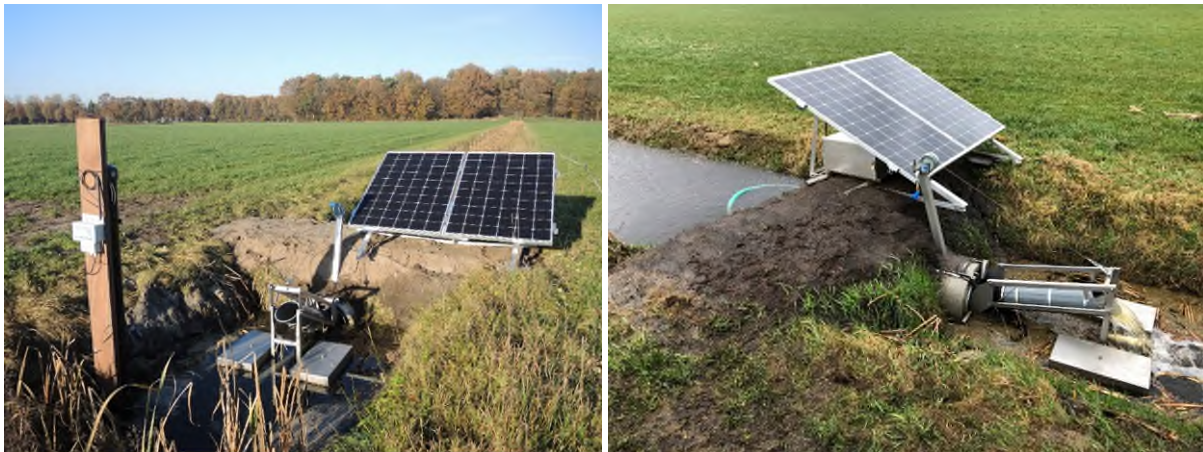
Figuur 1-8: SAWAX (2.0) stuw in Stegeren (foto's: Gé van den Eertwegh), waarmee in de bovenstroomse haarvaten van het watersysteem een tot 0.5 m hoger waterpeil gerealiseerd kan worden dan in de benedenstroomse leggerwaterloop. Het bereik van het door het waterschap gevoerde peilbeheer kan zo tot in de haarvaten effectief worden.
