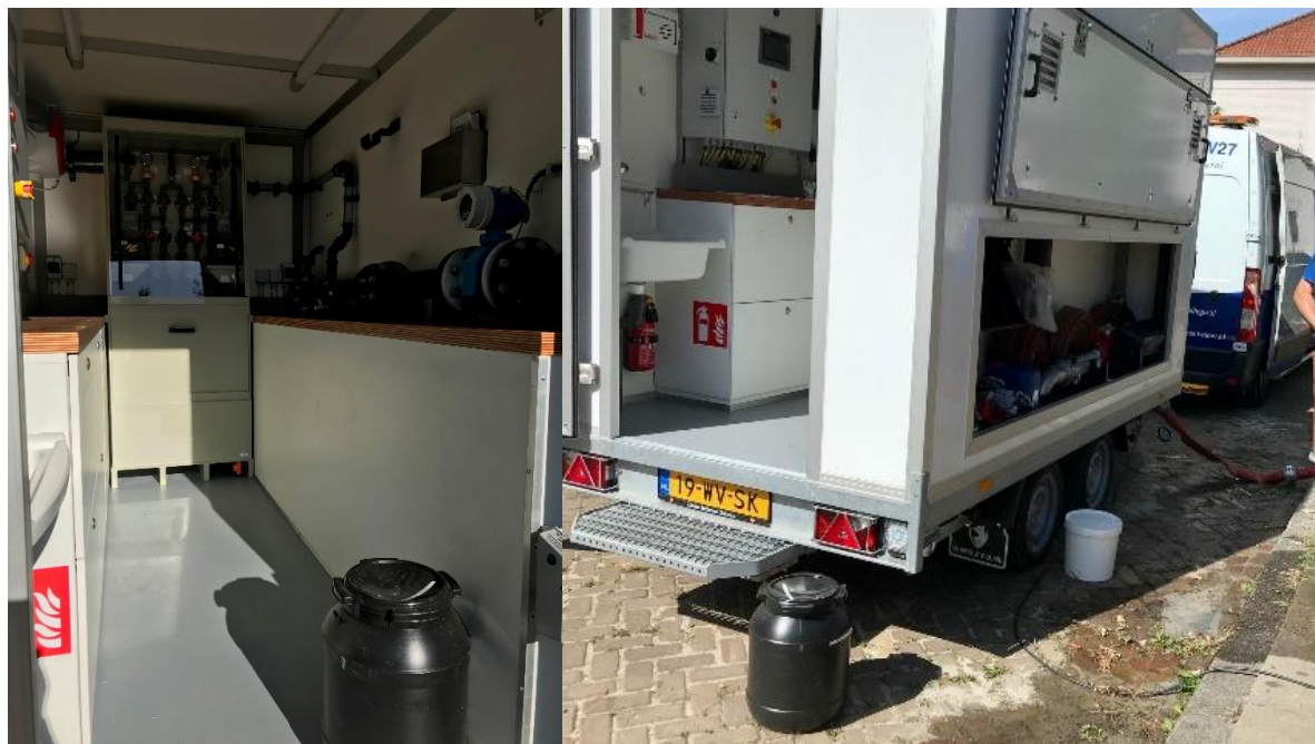
Foto 2 Hulpapparatuur voor de desinfectie van drinkwater in het leidingnet (foto's Brabant Water en Evides Waterbedrijf).
