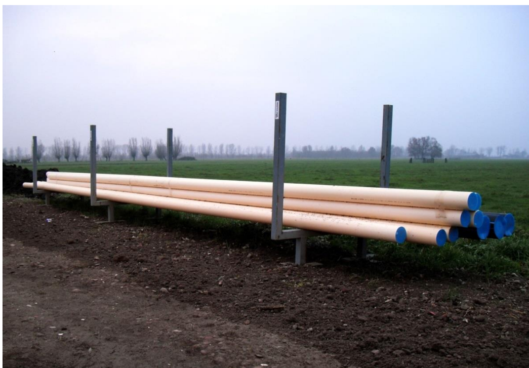
Foto 3 De wijze van opslag van buizen op werklocaties.
