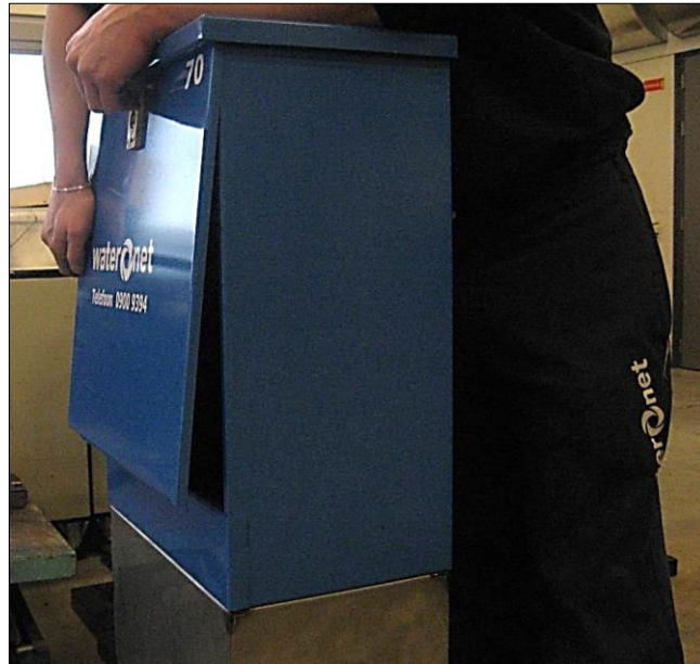
Het plaatsen van de deur van een watermonsterkast (foto: Waternet).
