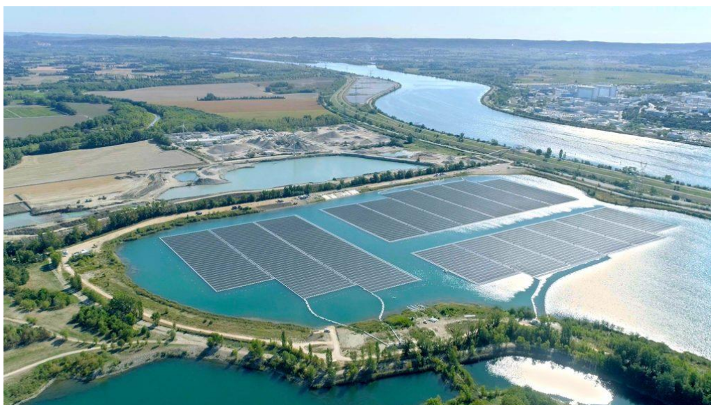
Figuur 6-1: Zonnepanelen op water, O'MEGA1 project in de Rhône vallei in zuid Frankrijk 10 en bij Evides waterbedrijf in Rotterdam 11 .
