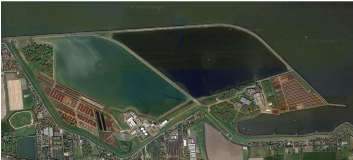
Bovenaanzicht bekkens van PWN (bron: Google maps, d.d. 01-07-2020)
