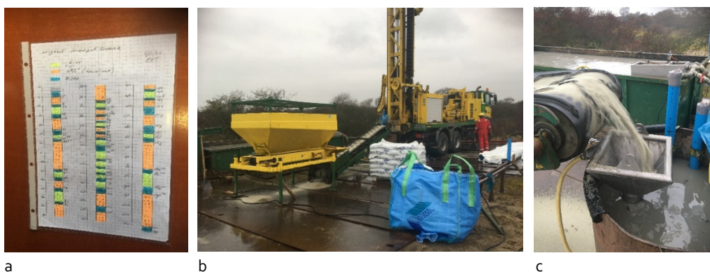
FIGUUR 4-14: A. AANVULSCHEMA VAN HET BOORGAT GEBRUIKT DOOR HAITJEMA (ZIE OOK BIJLAGE IV). B. OPSTELLING VAN DE BENODIGDE MATERIALEN VOOR AANVULLING VAN HET BOORGAT, C. AANVULLING VAN HET BOORGAT.
