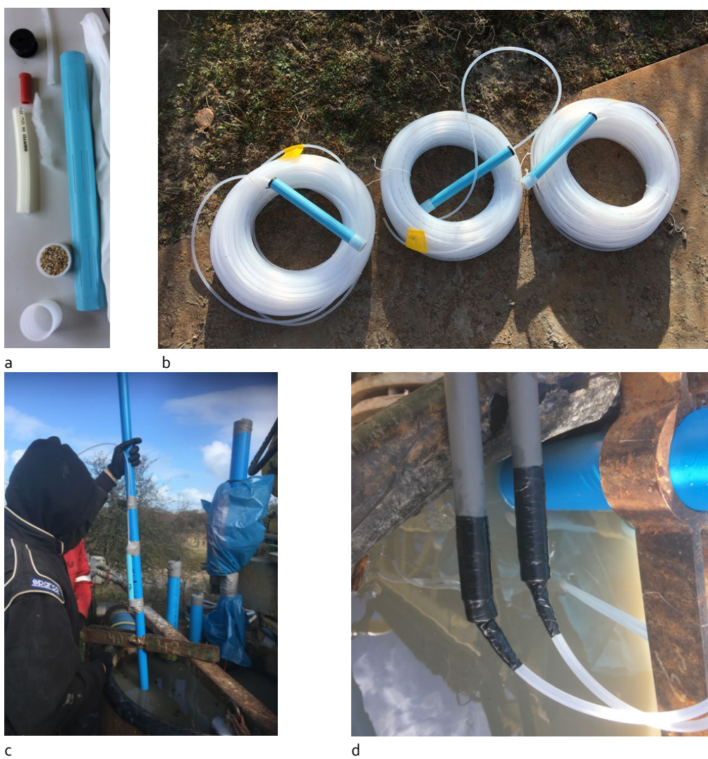
FIGUUR 4-8: A. MATERIAAL GEBRUIKT VOOR DE CONSTRUCTIE VAN MINIFILTERS, B. MINIFILTERS VERBONDEN AAN PE-SLANGEN, C. BEVESTIGING VAN MINIFILTER AAN PEILBUIS, D. PE-SLANGEN VERBONDEN AAN PVC-BUIZEN.
