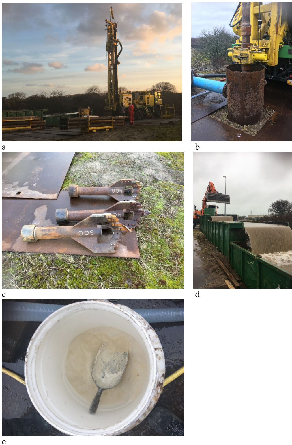
FIGUUR 4-1: A. BOORSTELLING, B. PLAATSING VAN DE BOOR(STANGEN) IN HET BOORGAT, WELKE VANUIT DE SUPPLETIEBAK ONDER DRUK WORDT GEHOUDEN MET DE BOORSPOELING C. BOORKOPPEN MET VERSCHILLENDE DIAMETERS, D. TWEE AANGEENGESCHAKELDE BEZINKBAKKEN EN OP DE VOORGROND DE DAARAAN GESCHAKELDE SUPPLETIEBAK DIE IS VERBONDEN MET HET BOORGAT, E. ANTISOL.
