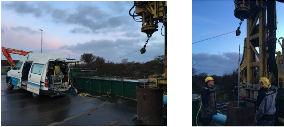
FIGUUR 4-4: UITVOERING VAN DE BOORGATMETING DOOR DELTARES.
