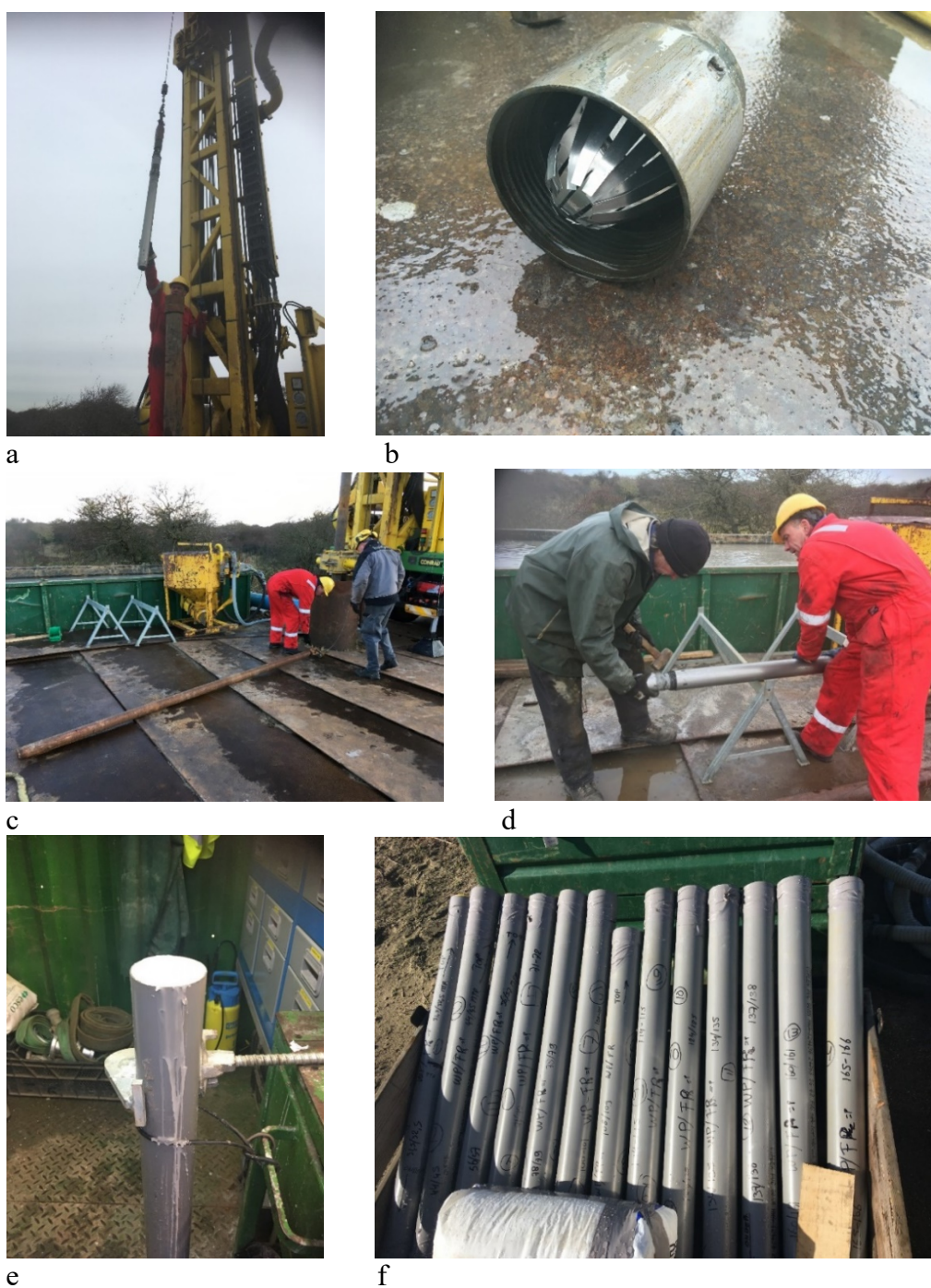
FIGUUR 4-3: A. STEEKAPPARAAT DAT WORDT INGEBRACHT IN DE HOLLE BOORSTANGEN, MET DAARIN DE PVC STEEKKERN, B. TERUGSLAGKLEP ONDERAAN HET STEEKAPPARAAT, C. PULS, D. OPENEN VAN HET STEEKAPPARAAT, E. AFDOPPEN VAN DE PVC STEEKKERN MET PARAFFINE, F. AFGEDOPTE STEEKKERNEN.
