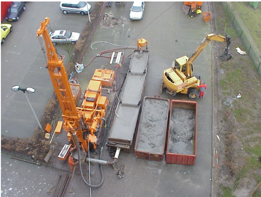
Figuur II-1: Boorstelling zuigboren
