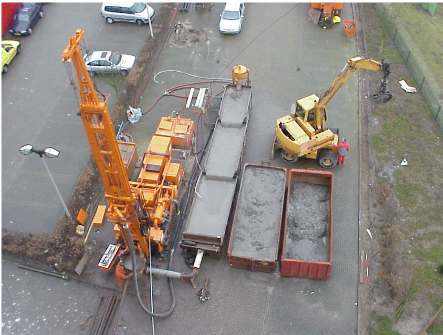
Figuur II-1: Boorstelling zuigboren
