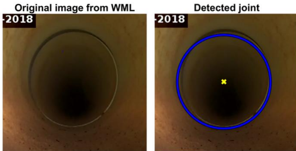
Figuur 13. Uitkomst van het algoritme wanneer toegepast op een verbinding in de beelden van WML, gefotografeerd onder een vergelijkbare hoek, bij benadering vanaf de lengteas van de buis.
