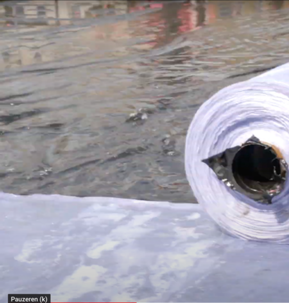
Aanbrengen tweede laag capillair geotextiel
