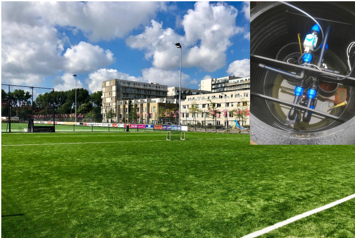
Figuur 12 Trainingsveld met capillaire irrigatie op Sportpark Laan van Spartaan. Inzet: regelput voor waterniveaus en debietmetingen
