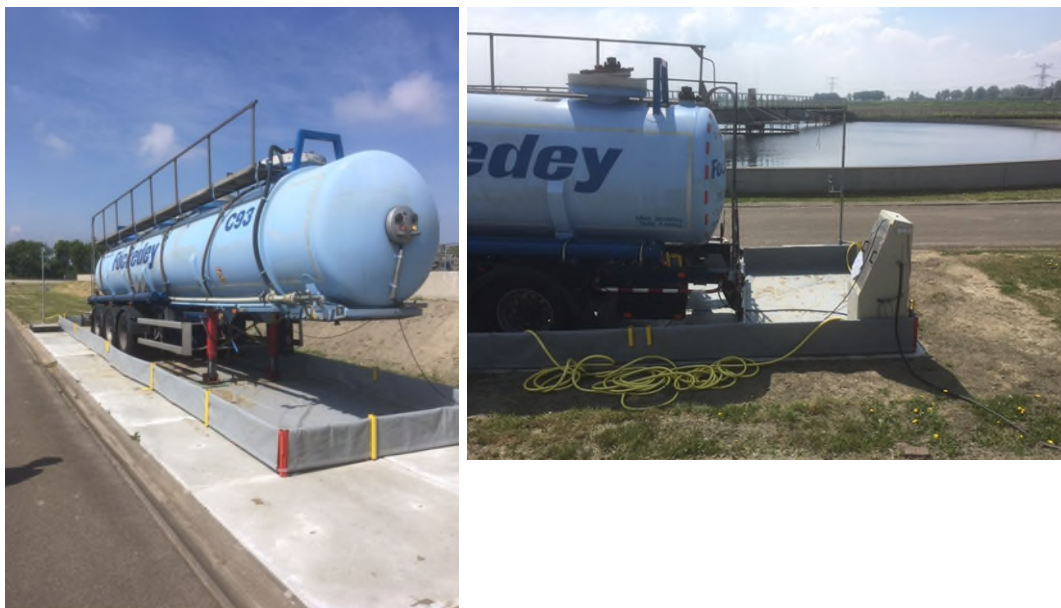
Figuur 2: Tankwagen, lekbak en doseerunit voor het doseren van het HerCauWer-vlokmiddel aan straat 5
