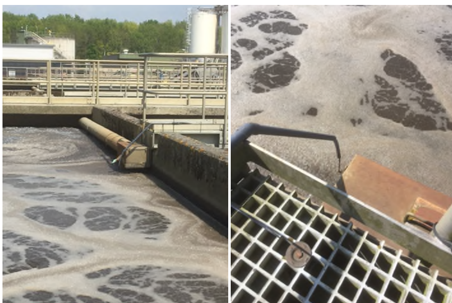
Figuur 3: Dosering van het HerCauWer-vlokmiddel aan het influent van straat 5 op Bath
