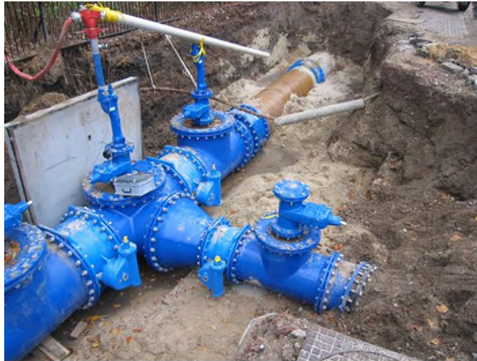
Foto 17 Aanleg van een leiding (checklist 3.6, onderdeel 6).
