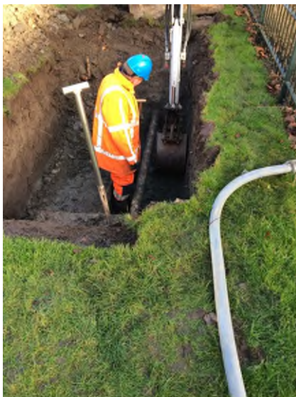
Foto 18 en 19 Werken in een droge werkput (checklist 3.6, onderdeel 6).
