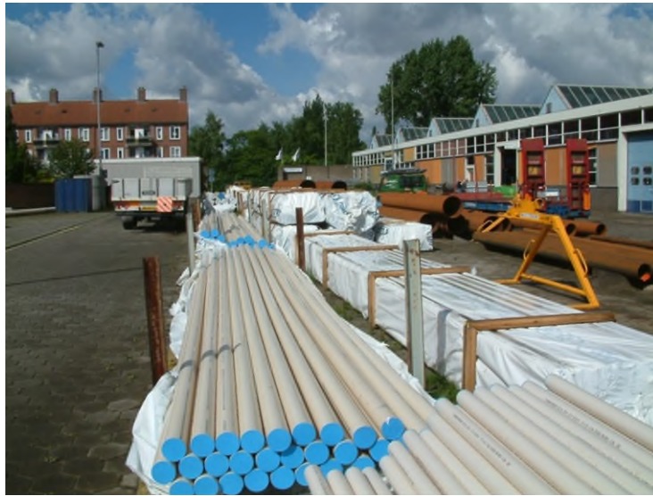
Foto 7 Buizen met 'hygiëne kappen' (doppen) en afdekfolie (checklist 3.3, onderdeel 1).
