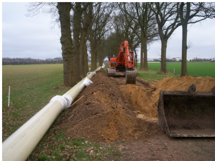
Foto 16 Bescherming van leidingmaterialen tijdens aanleg (checklist 3.5, onderdeel 7).
