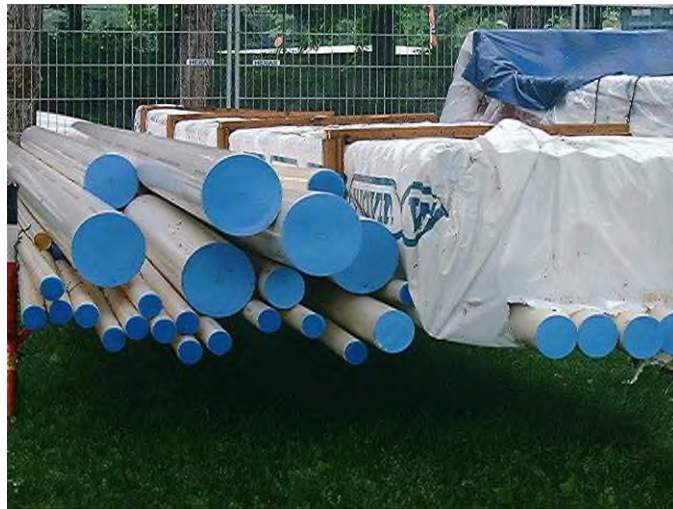
Foto 14 Bescherming van leidingmaterialen tijdens opslag op de werklocatie (checklist 3.5, onderdeel 4).
