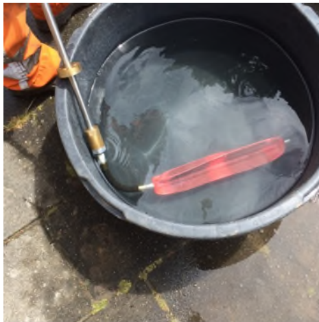
Foto 20 De desinfectie van een 'blaas' ten behoeve van het segmenteren van een leiding (checklist 3.6, onderdeel 3).
