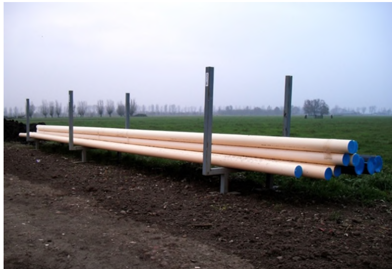
Foto 15 Bescherming van leidingmaterialen tijdens opslag op de werklocatie (checklist 3.5, onderdeel 5).
