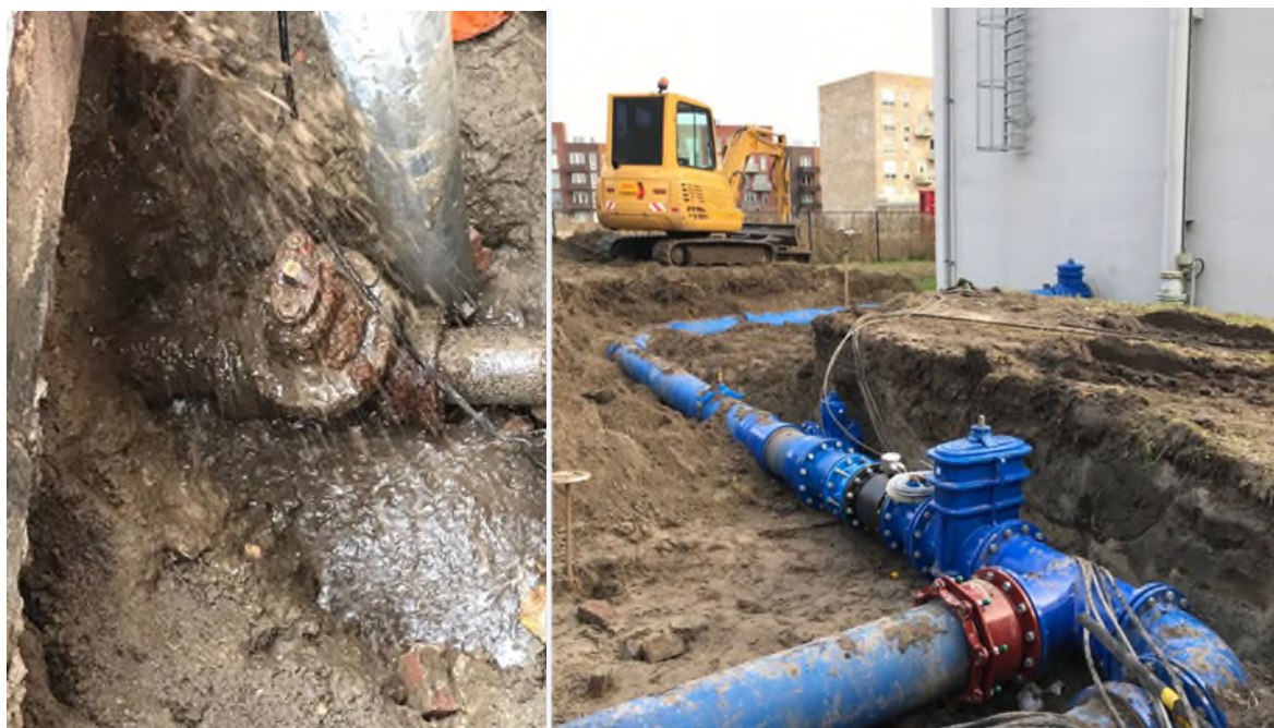
Oude afsluiter en nieuw aangelegde afsluiter, Dunea
