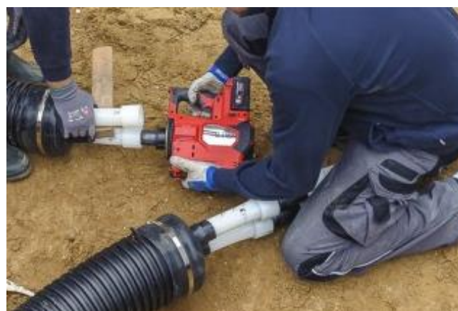
Boven links: geplaatste knelfitting op een Rehau RAUTHERMEX flexibele voorgeïsoleerde PE-leiding voor het maken van een aansluiting (Bron: hti-handel.de [11]).
