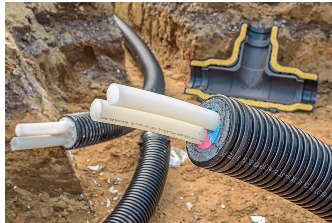
Voorbeeld van een duopijp-2-pijpsysteem (Uponor Ecoflex) voor een LT-warmtenet. Bron: si-shk.de [10].
