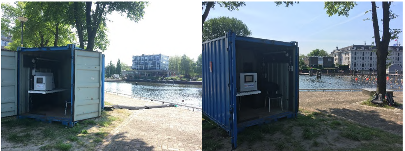
Figuur 60. Container met BACTcontrol op het Marineterrein. Op de linkerfoto is de aanvoerslang naar het zwemwater onder de zwarte matten zichtbaar.
