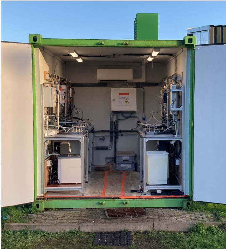
Figuur 11. ZOB-container van PWN waarin de flowcellen zijn geïnstalleerd. Rechts achterin (niet in beeld) bevindt zich de steeklans waarmee continu drinkwater uit de onderliggende transportleiding wordt bemonsterd. N.B. tijdens het maken van deze foto was de hittewerende verf nog niet aangebracht.
