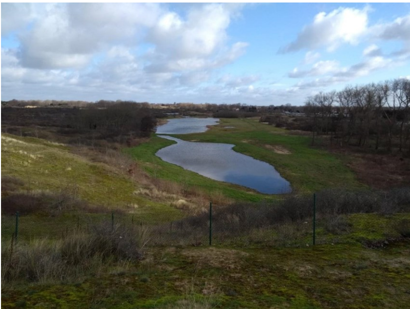
Figuur 5.7: Eén van de infiltratievijvers voor voorgezuiverd RWZI-effluent in het St. André-systeem (VVSG, n.d.-b)
