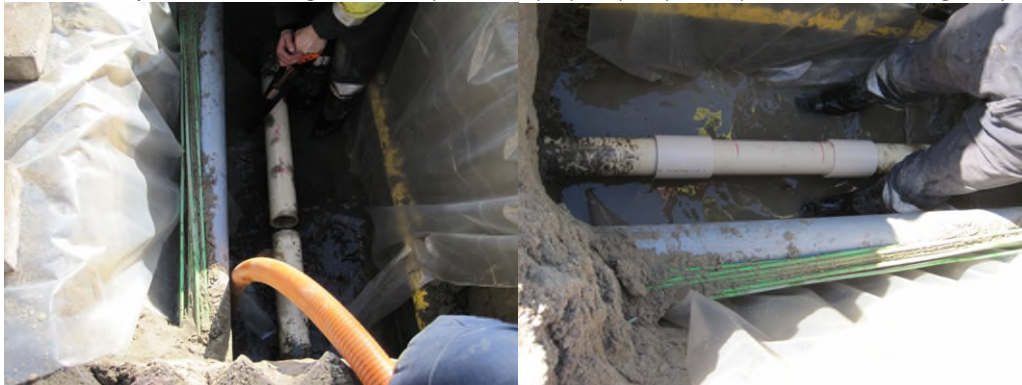
Foto 3: Leiding wordt gezaagd, zorg voor ondersteuning zodat hij niet in het water valt.
