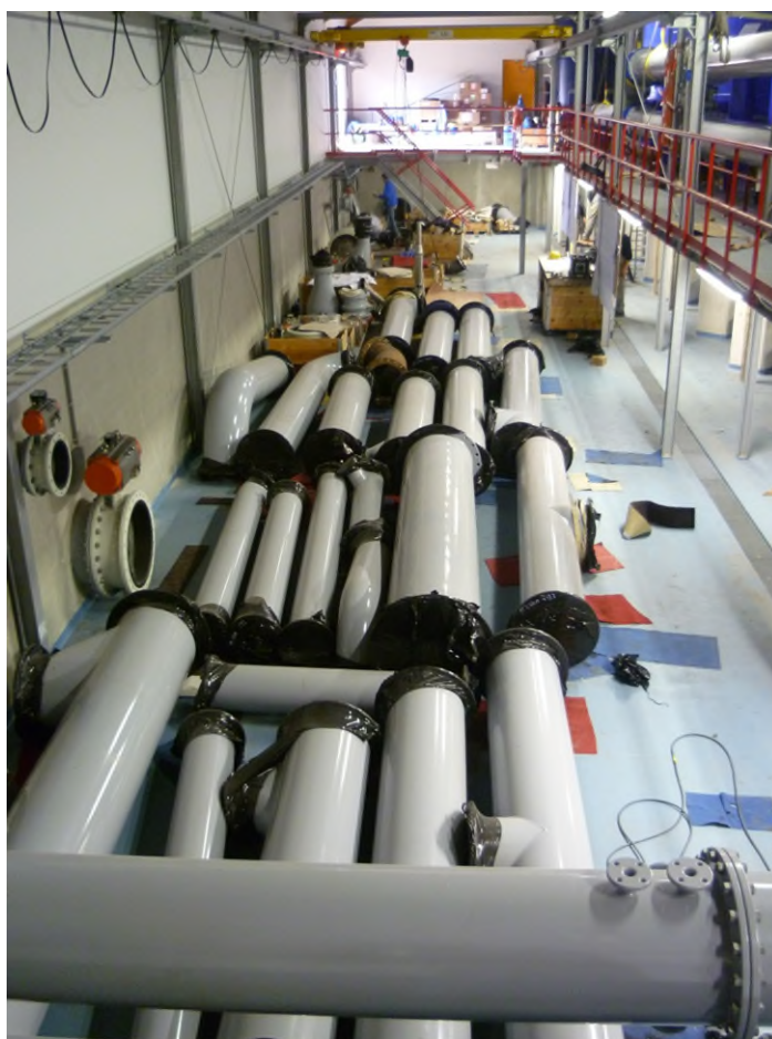
Foto 6 Goed georganiseerde opslag van materialen tijdens bouwactiviteiten (foto Vitens).
