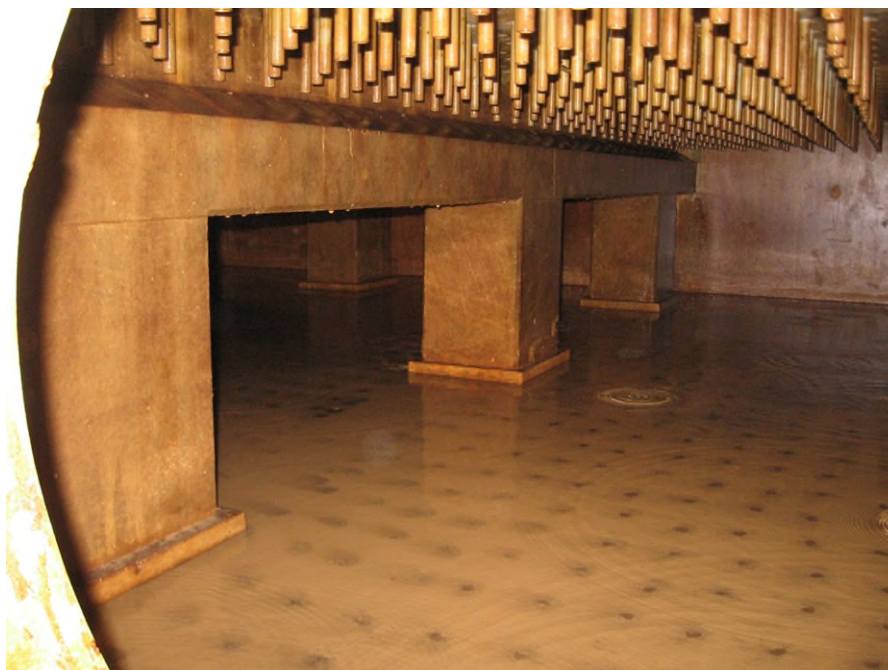
Foto 3 Goede toegankelijkheid van een filter (foto Evides Waterbedrijf).
