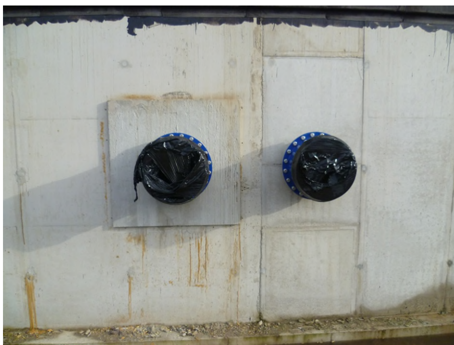
Foto 1 Bescherming tegen invloeden van buitenaf tijdens de bouw (foto Vitens).
