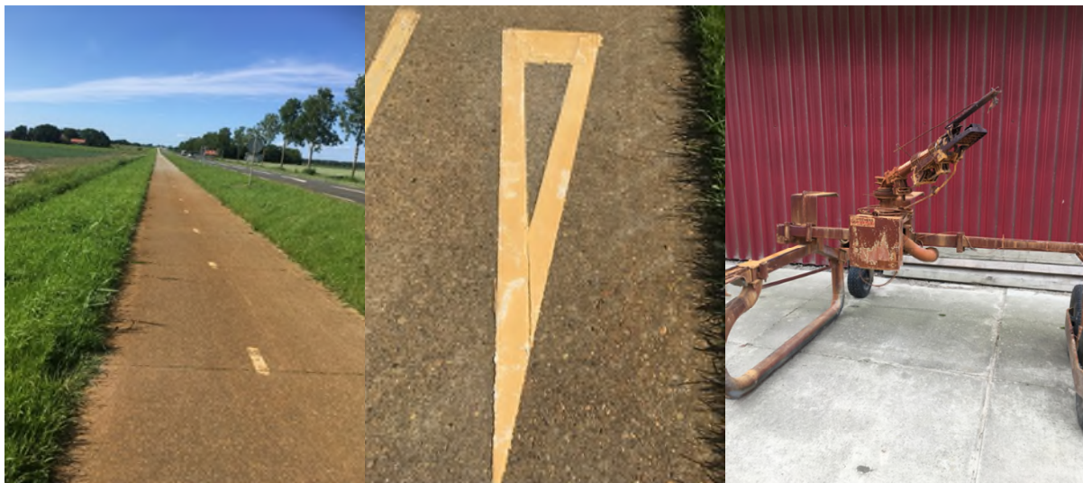
Figuur 1.3: Roodkleuring fietspad in het Vuursteentocht gebied in Flevoland door beregening van naastliggend perceel met ijzerhoudend grondwater en roodkleuring van een relatief nieuwe stuitinstallatie die voor beregening wordt gebruikt (foto's: Bas van der Grift).
