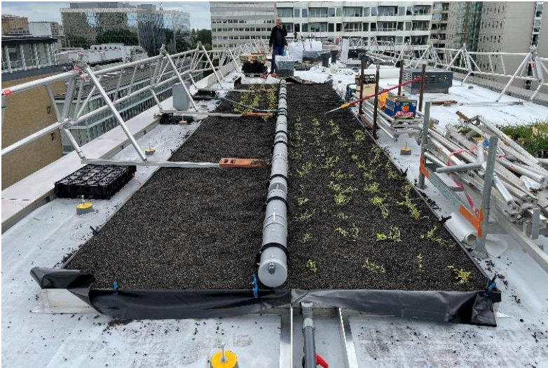
Figuur 2 Aanleg van het horizontaal doorstroomde helofytenfilter op het dak van Mannoury gebouw 3
