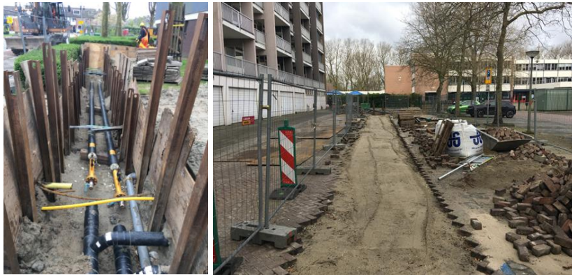
Figuur 8 De aanleg van een warmtenet in Dordrecht (bron KWR).
