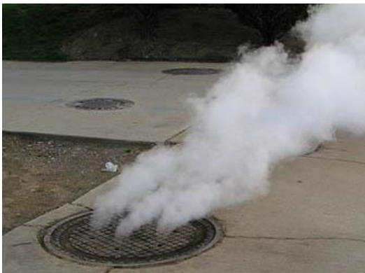
Figuur 2 Stoom die vrijkomt uit een eerste generatie warmtenet .
