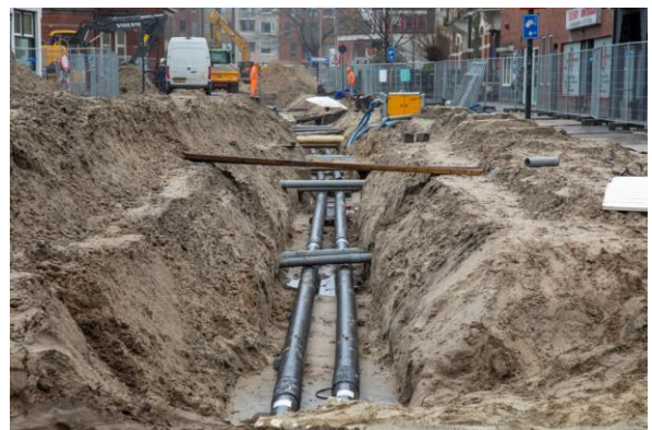
Figuur 5 De aanleg van een derde generatie warmtenetwerk in Enschede leidt tot veel grondroering.
