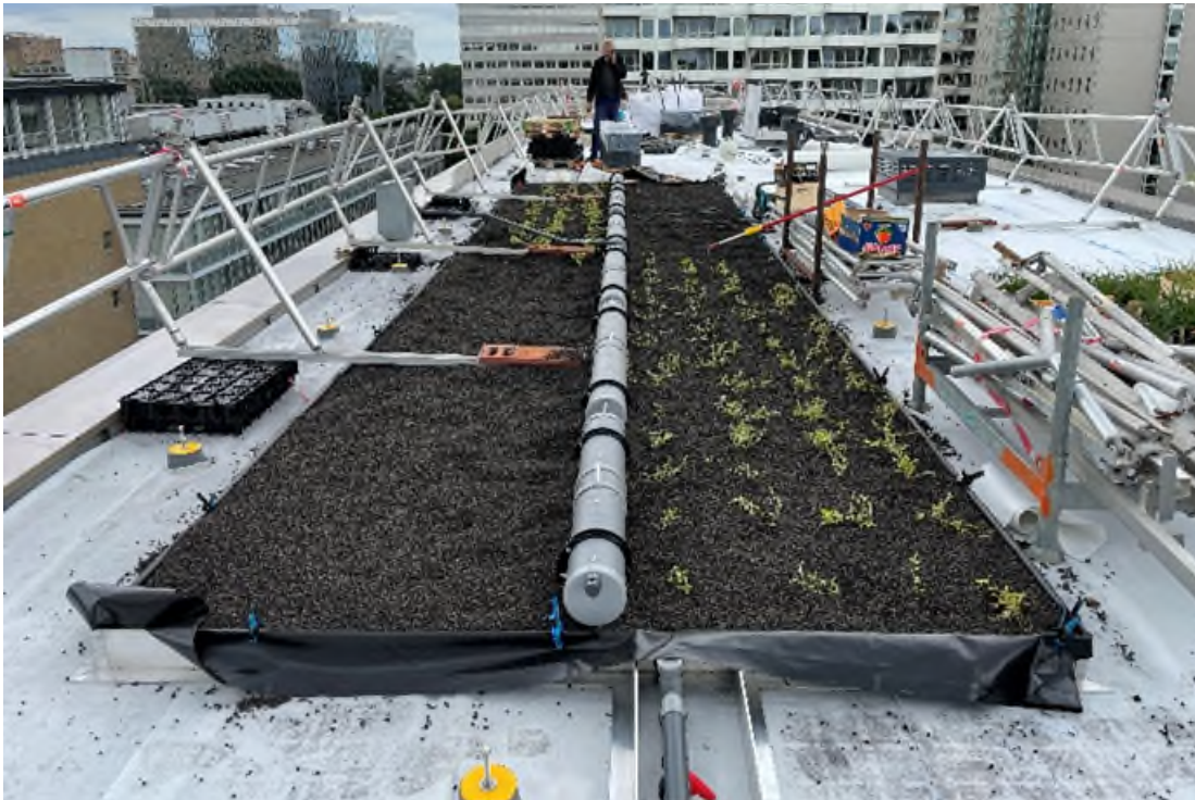
Figuur 4-2 Aanleg van het horizontaal doorstroomde helofytenfilter op het dak van Mannoury gebouw 3
