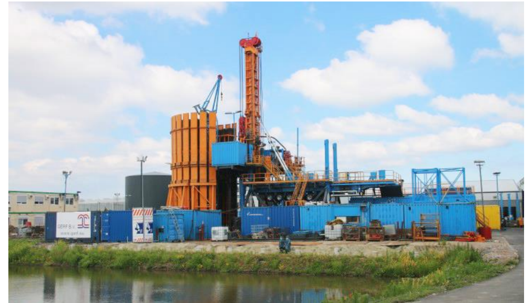
Boorinstallatie voor geothermie ('aardwarmte'). Bron: Geothermie Nederland [12].
