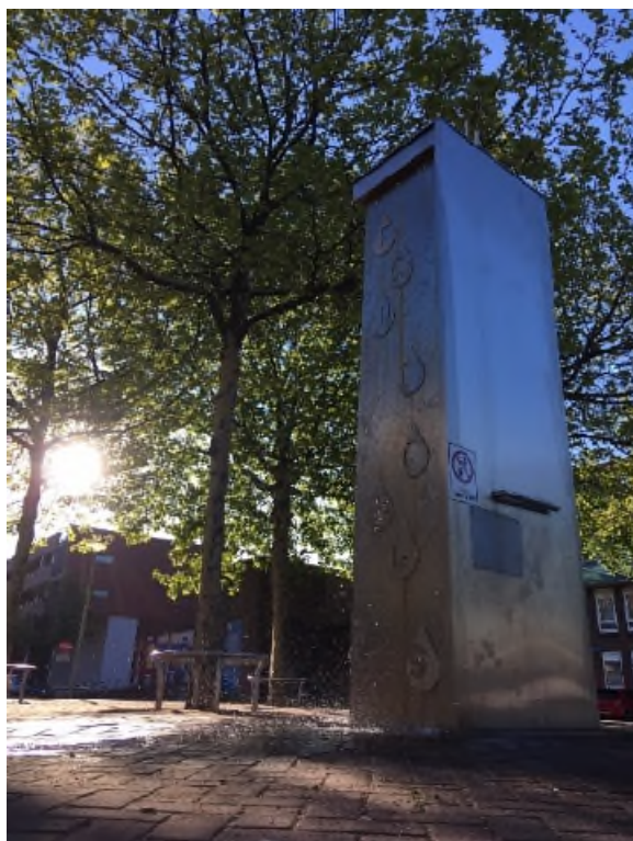
Figuur 6-1. Voordrukbuisk (waterzuil) inclusief hendel op het plein naast het Bluebloqs filter.
