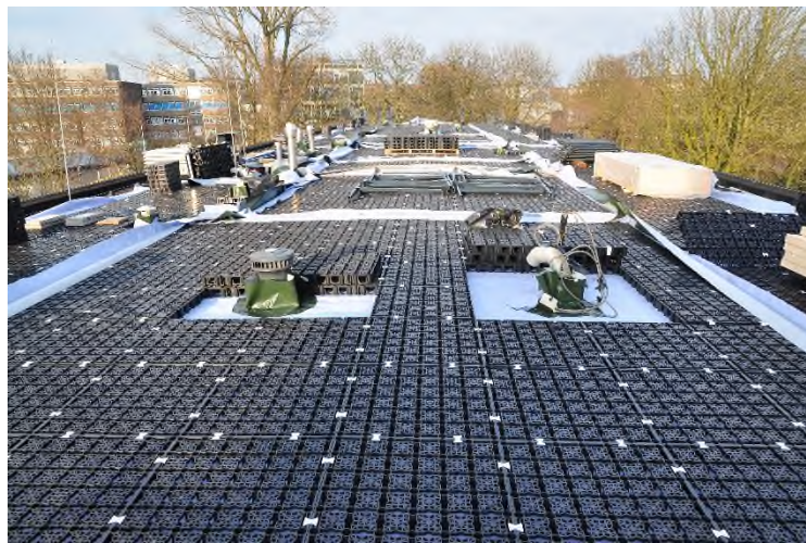
Figuur B5-1: Dak met Permavoid kratjes in aanbouw. Bron: www.nieuwestedelijkenatuur.nl .
