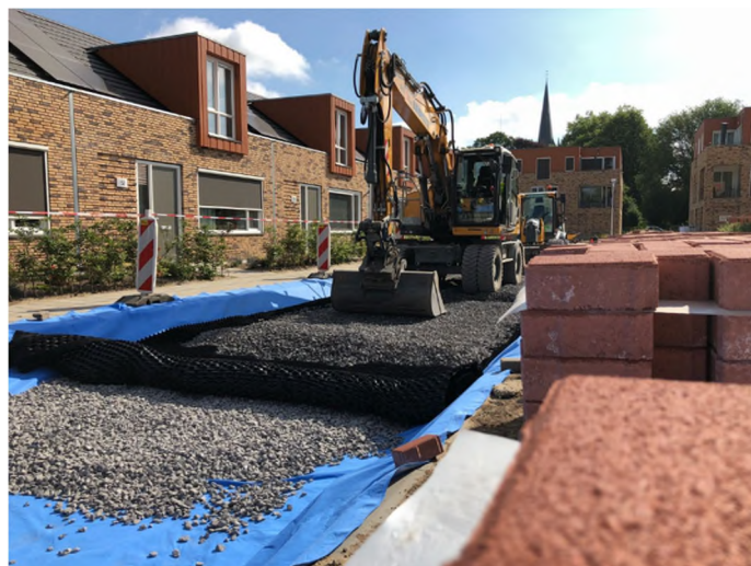
Figuur B5-4: AquaBase buffer in aanleg. Bron: www.aquabase.info .
