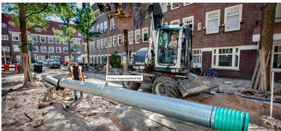
Figuur B5-2: DIT riolbuis wordt geïnstalleerd in project Amsterdam Rainproof (bron www.rainproof.nl ).
