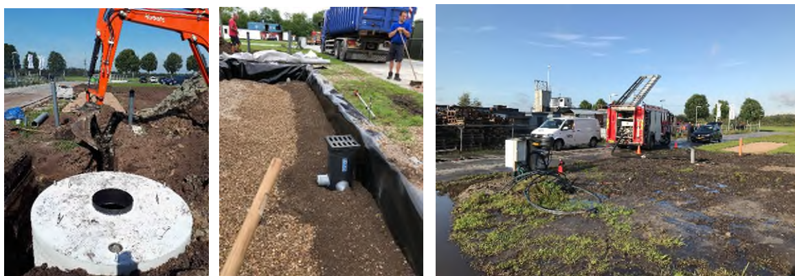
Figuur 11: situatie en foto's van de pilotlocatie in Wijster (bron Google Maps), de gele rechthoek is de locatie van de URS.
