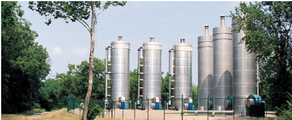
FIGUUR 2; VOORBEELD BELUCHTING EN ONTGASSINGSTORENS
