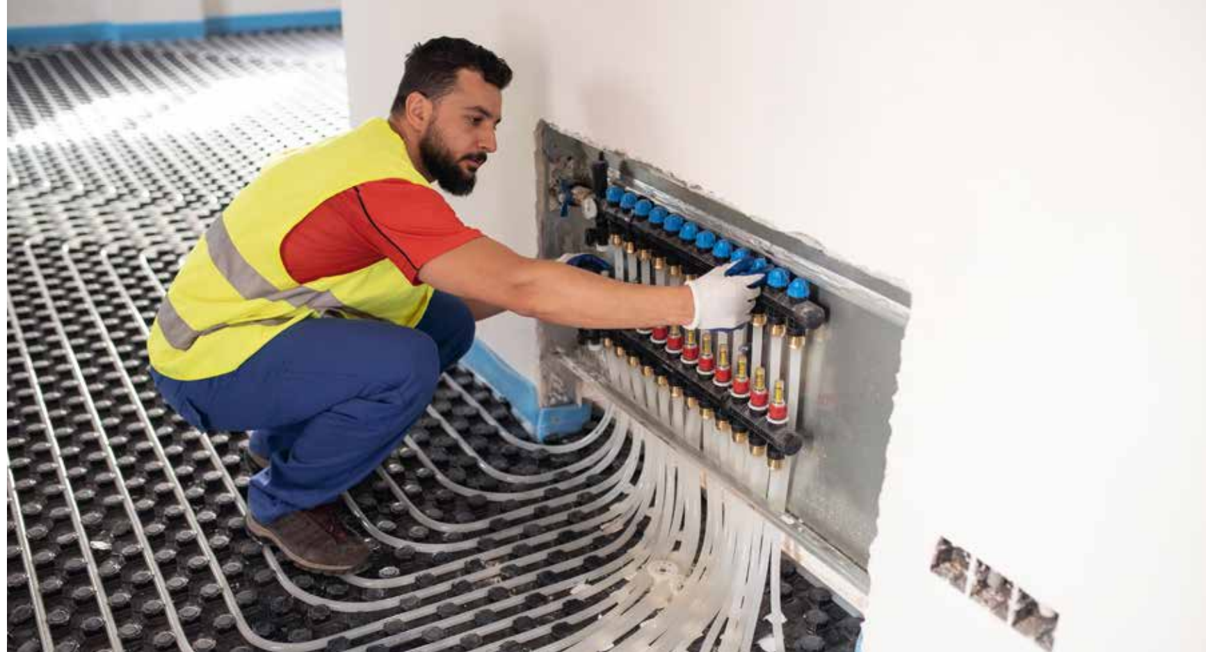
De aanleg van een laagtemperatuurverwarming
