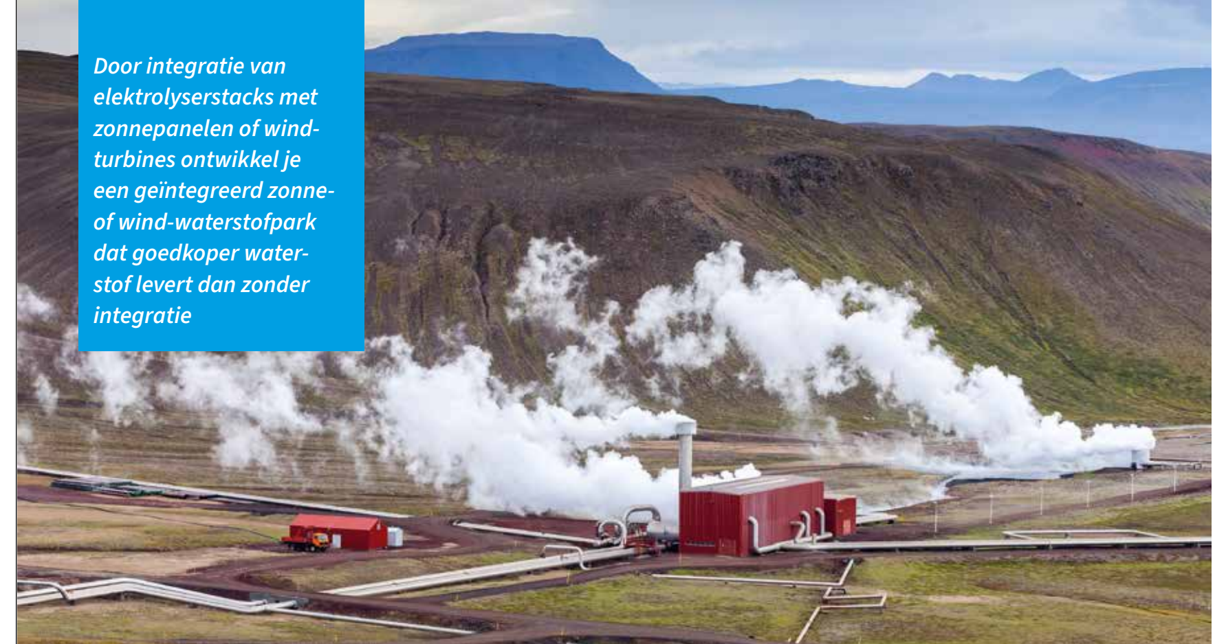
Geothermische centrale op IJsland
