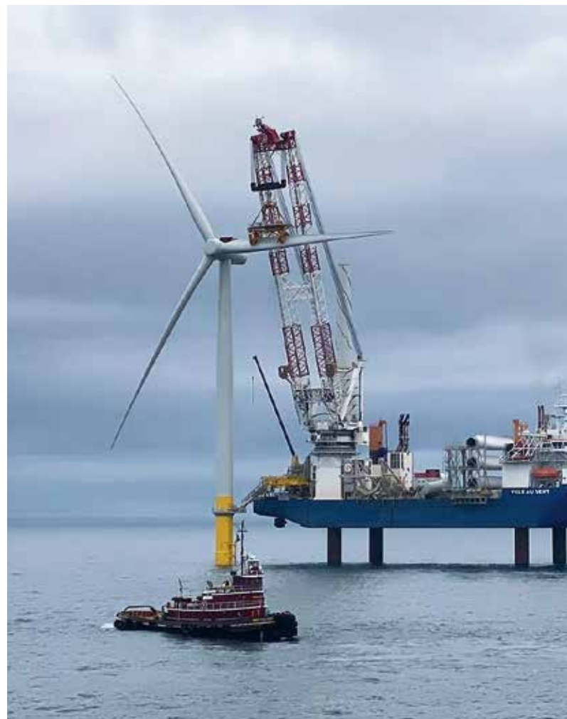
Windturbine in aanbouw [90]
