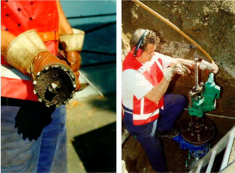
Figuur 7 Schulpuitname met behulp van aanboorapparatuur (links) en het resultaat van de aanboring (rechts), foto's gemaakt door Wim Maas (TWM)
