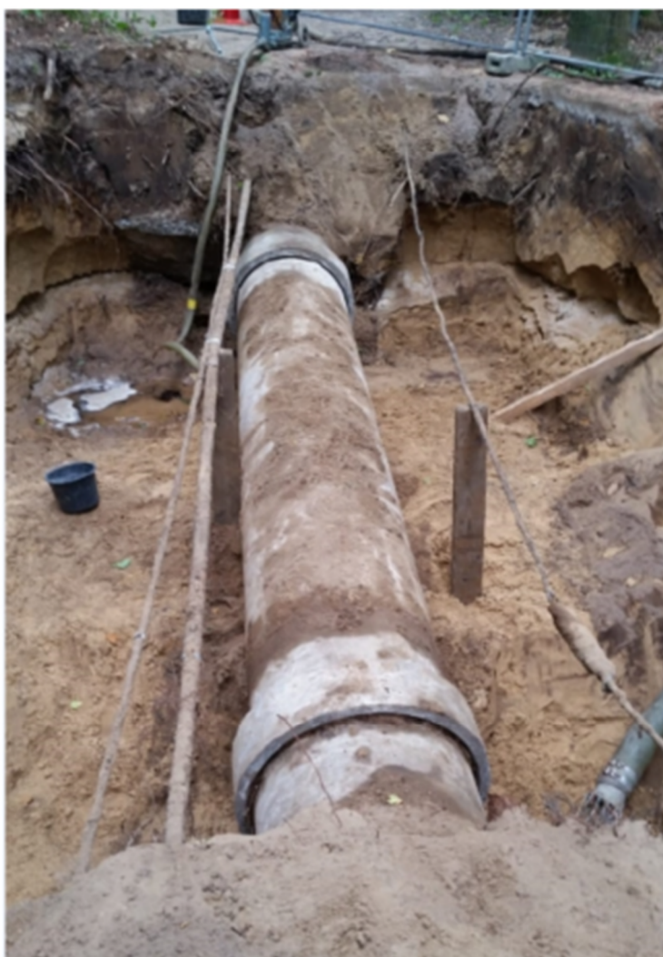
Foto 1. Ligging DN 800 AC leiding (foto Vitens)
