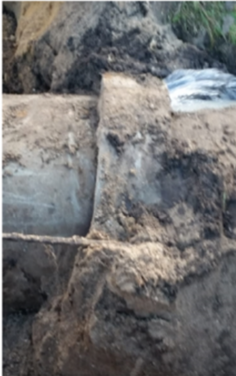
Foto 2. Lekkende koppeling (foto Vitens)
