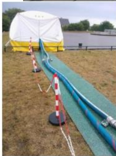
Foto 4 Werktent of constructie ten behoeve van een hygiënische zone buiten een gebouw (foto's PWN).
