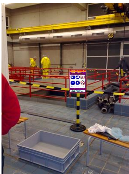
Foto 3 Een hygiënische zone binnen een gebouw (foto PWN).
