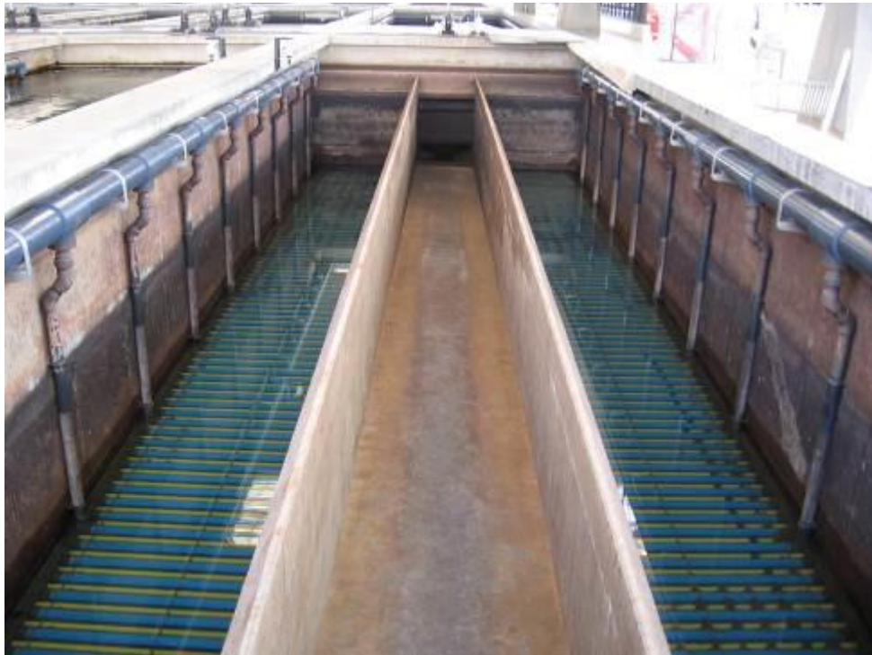
Foto 2.6 Werkzaamheden aan een snelfilter voor de behandeling van oppervlaktewater (effectzone oranje ) met een relatief kleine kans op verontreiniging van het water vallen in risicoklasse II (foto Evides Waterbedrijf).
