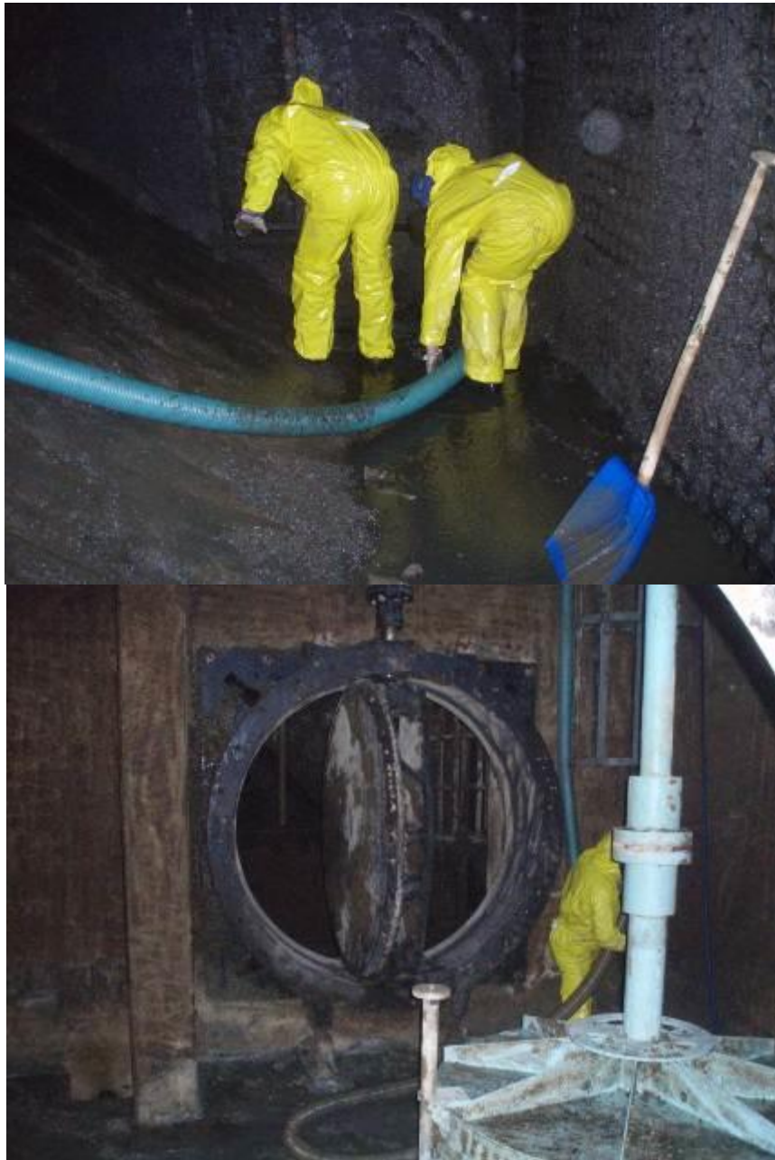
Foto 2.5 Werkzaamheden aan het uitlaatpompstation van spaarbekken 'Petrusplaat' (effectzone blauw ) vallen binnen risicoklasse I (foto's Evides Waterbedrijf).
