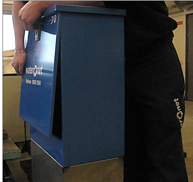
Foto VI.3 Het plaatsen van de deur van een watermonsterkast (foto: Waternet).
