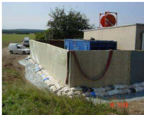
Figuur 5-10 Maatregelen bij de oeverinfiltratie winning Torgau-Ost in Duitsland, a) Bescherming van de ingangen van de putkelder met waterdichte afsluitingen; b) Bescherming van de energievoorziening (omvormer) met een muur en mobiele bronbemaling (Rambags et al. 2011). Het plaatsen van waterkerende bovengrondse muren of werken heeft niet de voorkeur in de uiterwaarden beneden het maatgevende hoogwater.
