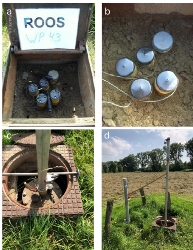
Figuur 2-2 Peilbuizen met druksensoren die zijn afgesloten zodat bij hoogwater het overstromingswater niet via de filterbuis het winpakket kan bereiken (a & b); peilbuis met opzetstuk om te zorgen dat het waterniveau lager blijft dan de top de peilbuis, waardoor het overstromingswater niet de filterbuis in kan stromen (c & d). Bron: a & b Rambags et al. (2011), c & d R. Prevoo (WML)
