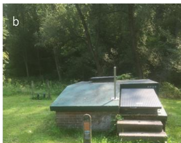
Figuur 2-3 a) Aanbrengen van folie langs de oevers van de Eyserbeek; b) Pompput nabij de Eyserbeek die bij hoogwater wordt afgeschakeld. Bron: R. Prevoo (WML)
