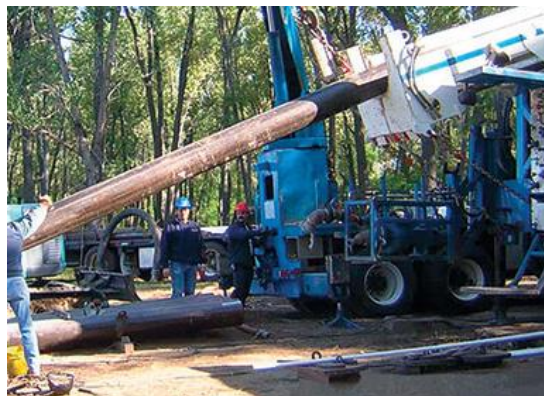
Figuur 5-6 Schuine put voor winning van water onder de oceaانبodem (links: Missimer et al. (2015), rechts: Straub (2016))
