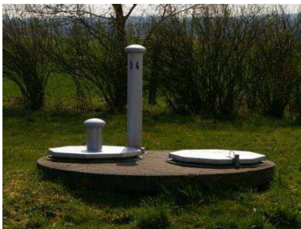
Figuur 5-10 Maatregelen bij de oeverinfiltratie winning Torgau-Ost in Duitsland, a) Bescherming van de ingangen van de putkelder met waterdichte afsluitingen; b) Bescherming van de energievoorziening (omvormer) met een muur en mobiele bronbemaling (Rambags et al. 2011). Het plaatsen van waterkerende bovengrondse muren of werken heeft niet de voorkeur in de uiterwaarden beneden het maatgevende hoogwater.
