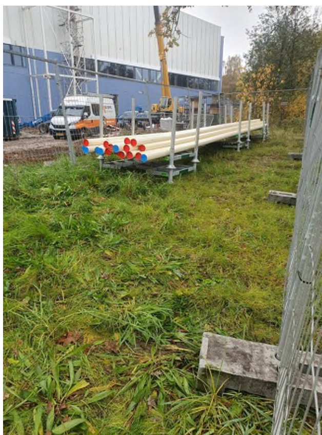
Foto 15 Bescherming van leidingmaterialen tijdens opslag op de werklocatie (checklist 3.5, onderdeel 5).
