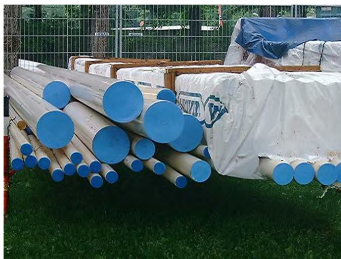
Foto 14 Bescherming van leidingmaterialen tijdens opslag op de werklocatie (checklist 3.5, onderdeel 4).
