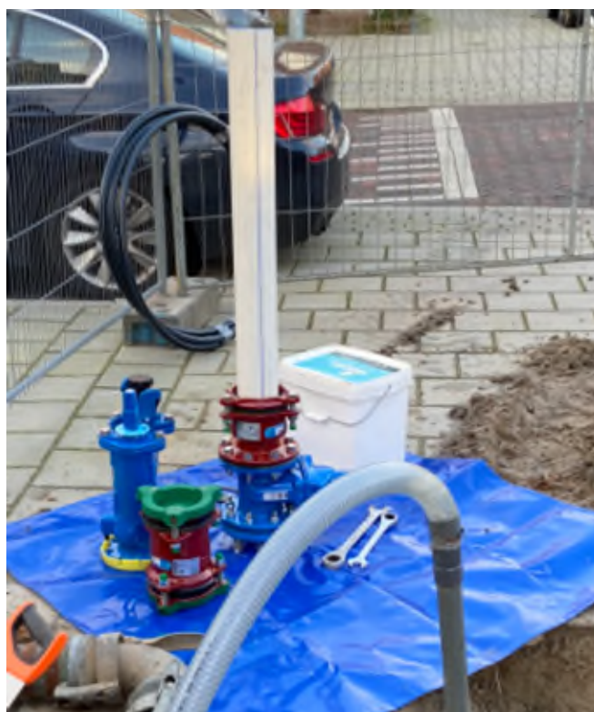
Foto 9 Het gebruik van een werkzeil (checklist 3.3, onderdeel 7).
