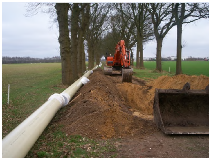
Foto 16 Bescherming van leidingmaterialen tijdens aanleg (checklist 3.5, onderdeel 7).
