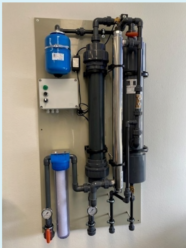
Figuur 9: Model-installatie van Mijn Waterfabriek voor de productie van hygiënisch water uit opgevangen regenwater.
