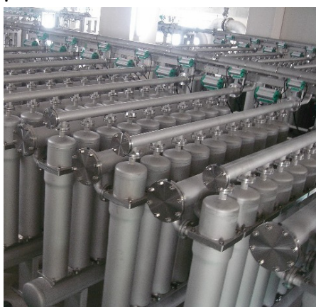
figuur 4.14: Keramische membraanfiltratie in Oshio (links), Ruwwaterkwaliteit (Hinogawa rivier) (rechts)
