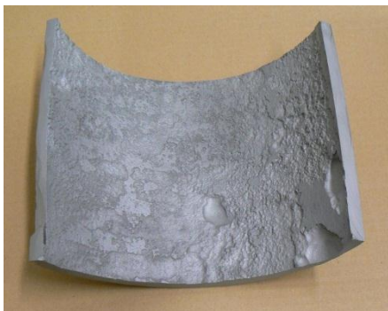
Figuur 4-4 GGIJ scherf na verwijderen corrosiedeklaag
