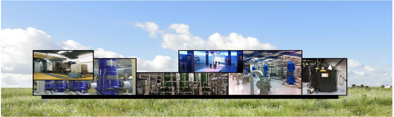
Abb. 5: Impression der im Bau befindlichen Multi-Source-Trinkwasserproduktion (Kamerik, NL; 300 m 3 /Stunde)
