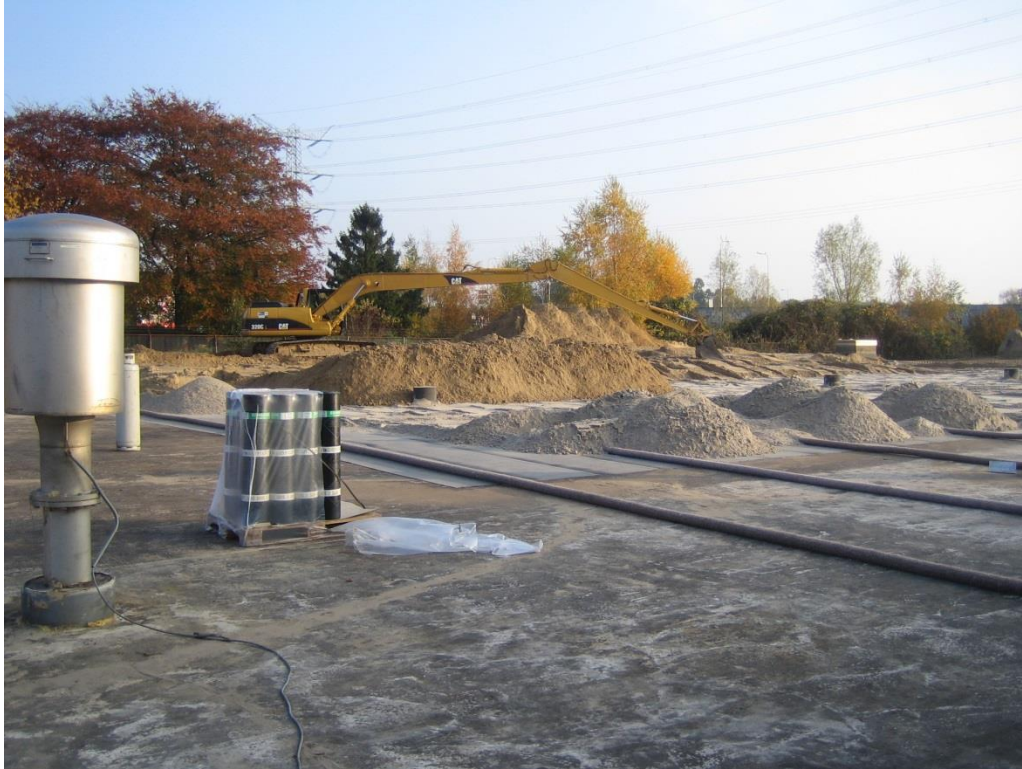
Figuur 8 Dak van een drinkwaterreservoir bestaande uit dakbedekking (zand en grond moeten nog worden aangebracht).
