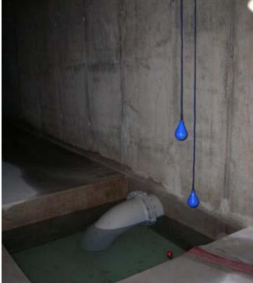
Figuur 12 Zuigkuil met niveaumetingen.
