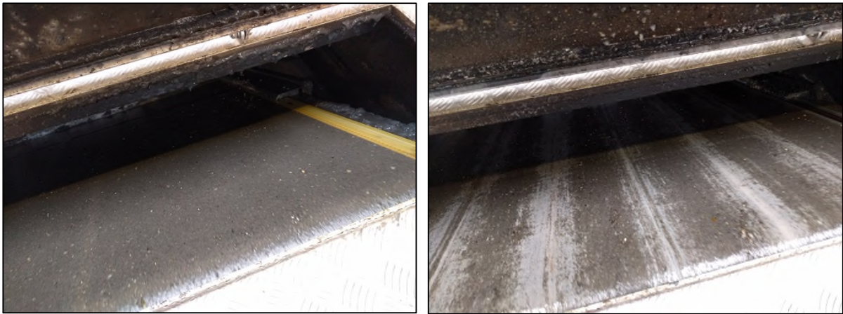
Foto 4: Fijnzeefbanden met filterkoek. Op de rechter foto is de verminderde werking van een vervuilde zeefband te zien
