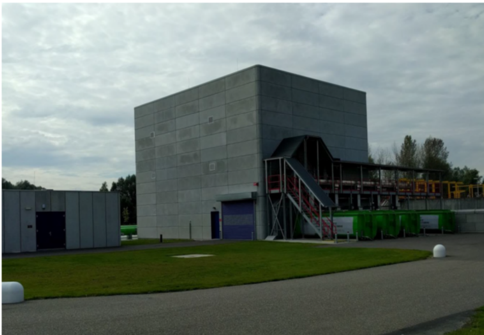
Foto2: Fijnzeefgebouw rwzi Aarle-Rixtel
