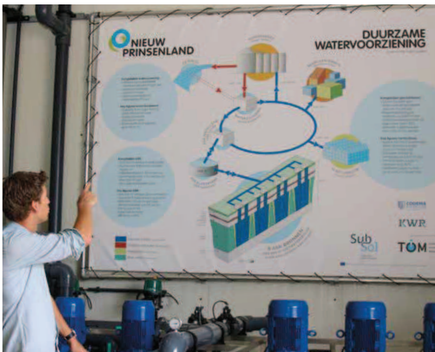
De gietwaterfabriek kan tijdens de bietencampagne 60 m 3 water per uur zuiveren. Dit water kan bij vraag rechtstreeks naar de telers óf naar de ASR-bronnen.
