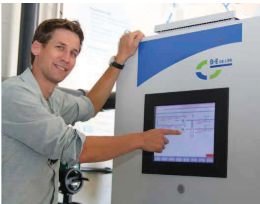
Koen Zuurbier toont op de monitor van het pompstation hoe de waterstromen in juli lopen.
