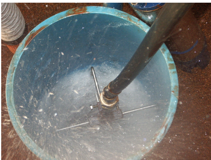
figuur 3 Regeneratie met hogedrukreiniging Macharen (Brabant Water)
