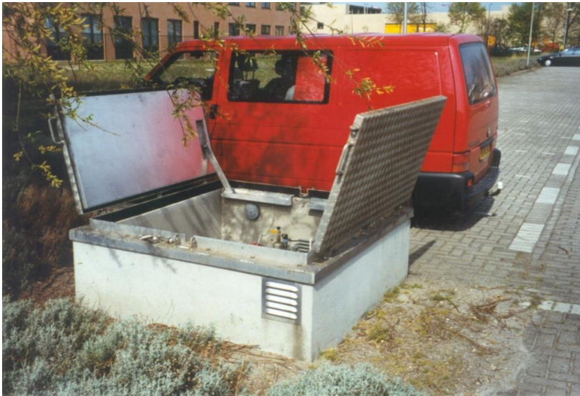
Figuur II-3 Afwerking bron met half-bovengrondse putbehuizing
