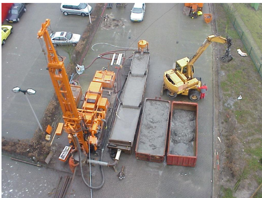
Figuur II-1: Boorstelling zuigboren
