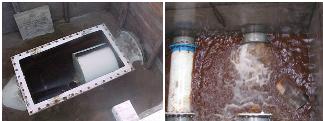
Figuur 32-18 Voorbeeld van leidingproppen (links) en schoonspoelen van terreinleiding (rechts) (foto's: Pieter Dammers, Dunea).
