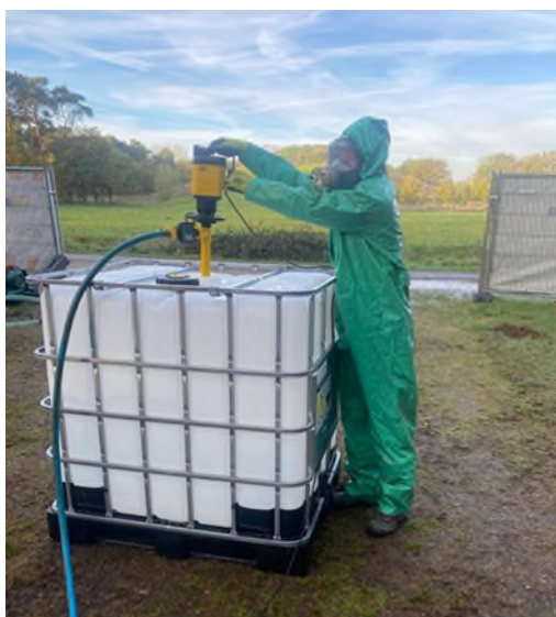
Figuur 35-8 Het gereedmaken van een regeneratie met het regeneratiemiddel chloorbleekloog (foto Wim Lemmens, Brabant Water).
