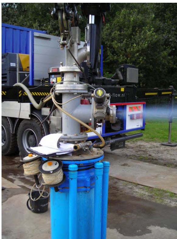
Figuur 35-3 a. Jutteren [SBW, 1997], b. Ontluchting bij jutteren, waarbij het waterniveau in de winput na wegdrukken weer omhoog komt.
